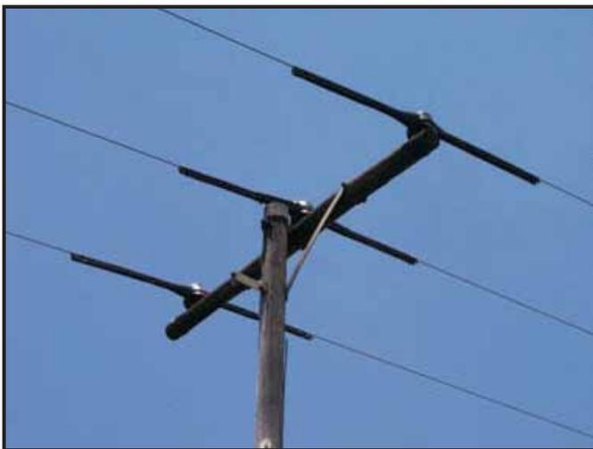
**Figure 3:** "Protecteurs de rapaces " sont utilisés pour isoler les conducteurs à un mètre de chaque côté de la traverse sur les structures du poteau T en bois
