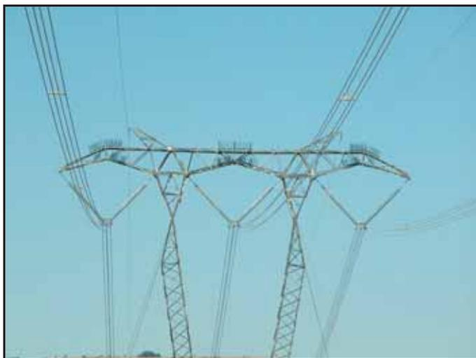
sur certaines zones à haut risque sur les tours, par l'installation des perchoirs dissuasifs comme les “Dispositifs de protection des oiseaux” illustrés à la Figure 6. La nidification est contrôlée en général en réinstallant les nids problématiques aux zones sans risques des tours sous la supervision des ornithologues.
